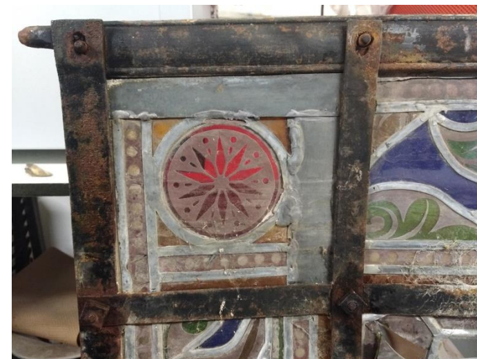
Fig. 5. Zia, taller de restauración harri (d) ura. Detalle de intervenciones anteriores en uno de los paneles de la vidriera SIII, año 2021. Amaya Sánchez Bakaikoa.
