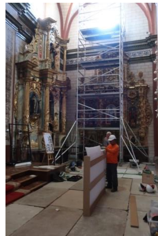
Fig.17. Olite, parroquia de San Pedro. Protección del suelo y uso de medios auxiliares en el interior para las revisiones, colocación y sujeción de la vidriera SIII, año 2022. Amaya Sánchez Bakaikoa.
