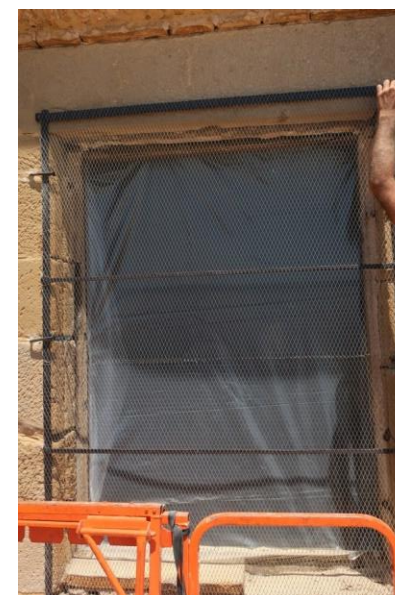
Fig. 16. Olite, parroquia de San Pedro. Colocación de la malla de protección tras la revisión del marco desde el exterior, año 2022. Amaya Sánchez Bakaikoa.
